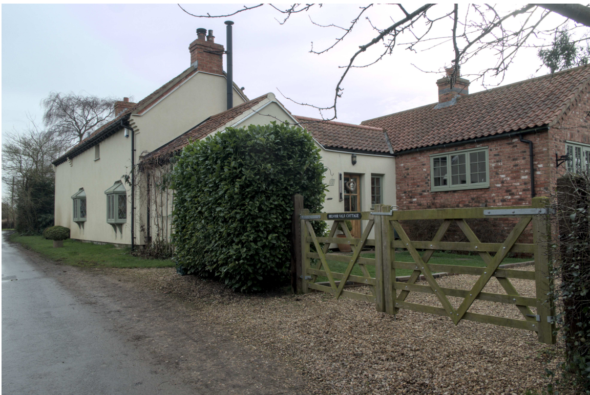
P1036079 - Belvoir Vale Cottage.
