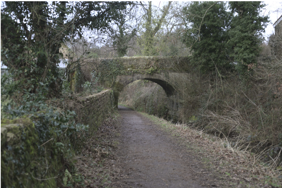
F47B6137 - Canal Bridge.
